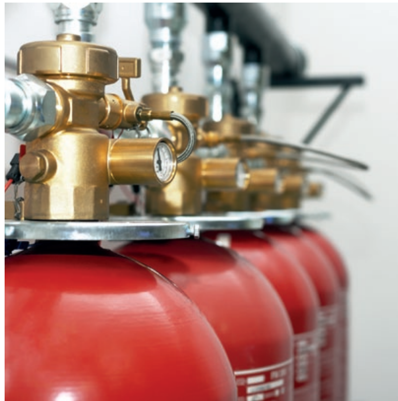
Löschgasbatterie
