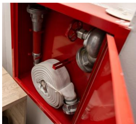
Beispiel eines RPC Hydrant F Wandhydranten
